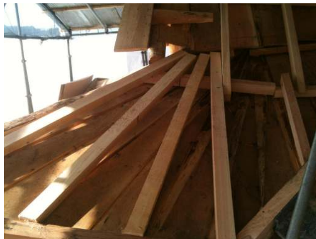
선자서까래 위에서의 주심도리 상 배게목 설치
