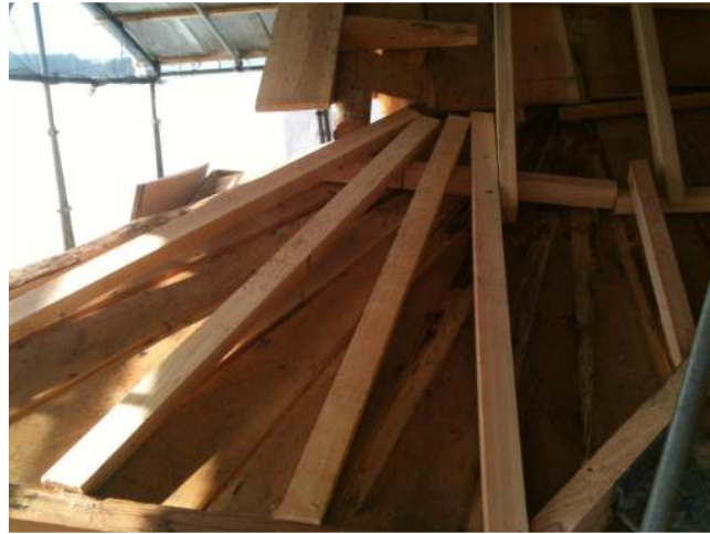
선자서까래 위에서의 중심도리 상 배계목 설치
