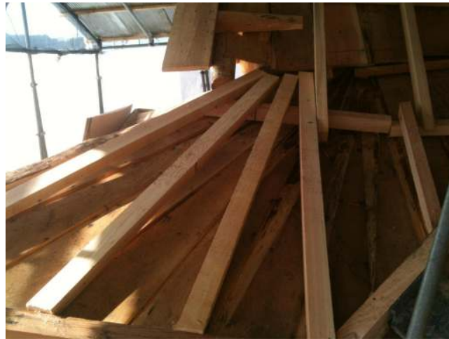
선자서까래 위에서의 주심도리 상 배게목 설치
