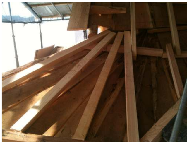
선자서까래 위에서의 주심도리 상 배게목 설치
