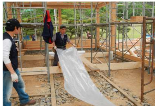
습윤 방지위한 비닐 설치
