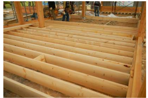
마루 장선 설치
