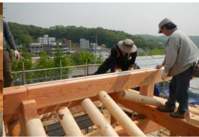
(중도리 설치 작업2)
