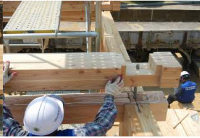
(창방 위에 평방 설치)
