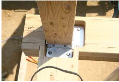
(평방 위에 철물 설치)
